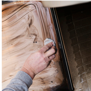
Reinigen Sie das Innere der Scheibe mit einem feuchten Tuch, dass Sie in die ganz feine Asche im Ofen eingetaucht haben.
