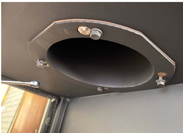
1. Lösen Sie zwei der Schrauben über Kreuz.
